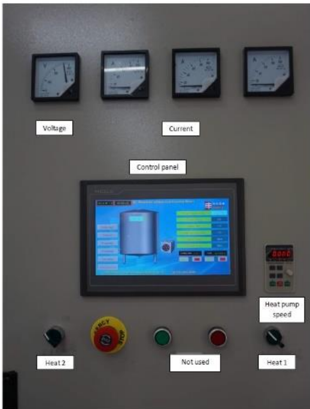
Figure 1 : 温度控制面板 ( 包括了温度的显示 , 搅拌电机的工作(及工作频率)以及加热器的旋钮 )
