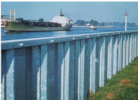
Abb. 62: Schutzgeländer einer Schleusenanlage (Spundwand)
