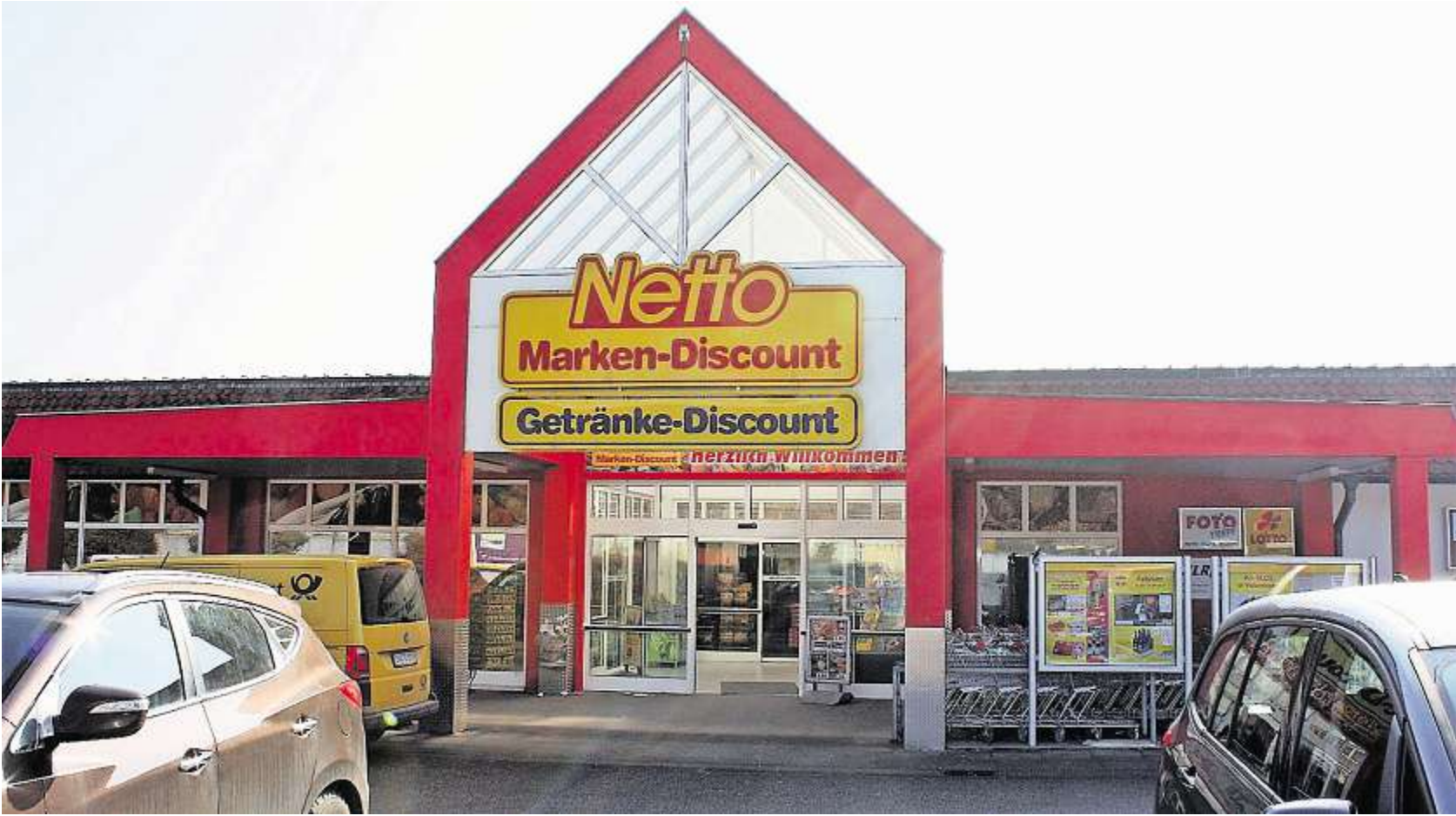
Der Netto-Markt in Kareth wird abgerissen und modernisiert. Am 29. Oktober soll er neu eröffnen.
