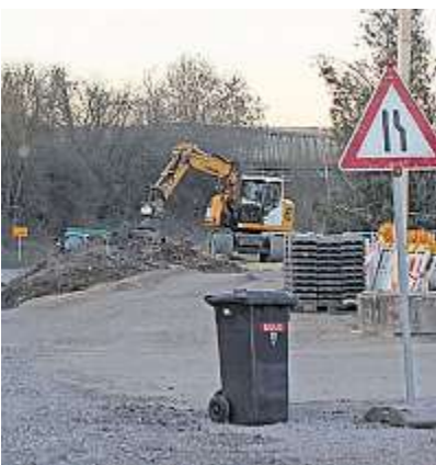
Die Bauarbeiten für den Vollausbau der Bahnhofstraße in Sinzing beginnen am Montag. FOTO: GERTRAUD PILZ
