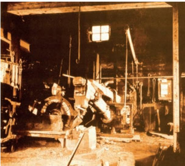
Bild 1.2: Wasserkraftgetriebener Eisenhammer (um 1780)
