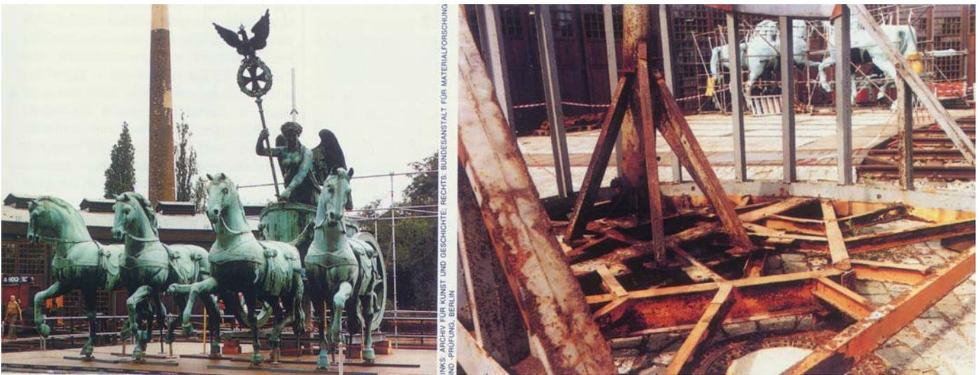
Bild 2: Während der Silvesterfeier 1989/90, im Freudentaumel nach der Wiedervereinigung Deutschlands, erkletterten Feiernde die Quadriga auf dem Brandenburger Tor. **Kontaktkorrosion** hätte diesem Akt des Übermuts ein böses Ende bereiten können: Die aus unlegiertem Stahl bestehende Stützkonstruktion stand in einer Kupferwanne, in der sich Regenwasser sammelte, und einige Stellen waren bereits durchgerostet. Das Viergespann wurde 1990 im Museum für Verkehr und Technik überholt.
